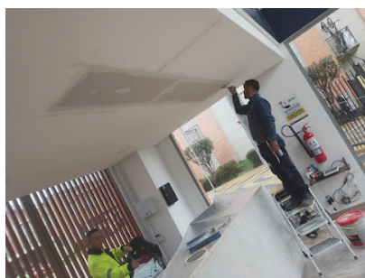
Mantenimiento paredes de portería
