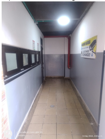
Mantenimiento de las paredes del cuarto de basuras
