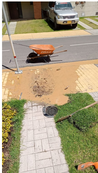
Arreglo de tubería en casas
