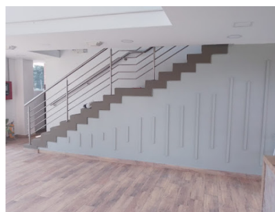
Mantenimiento paredes de portería
