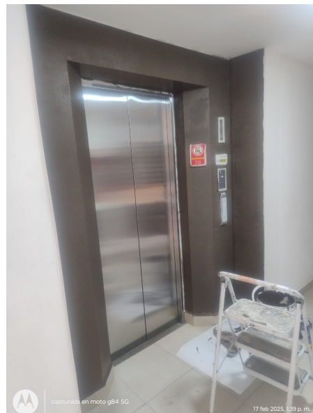
Mantenimiento de pintura en pasillos de las torres
