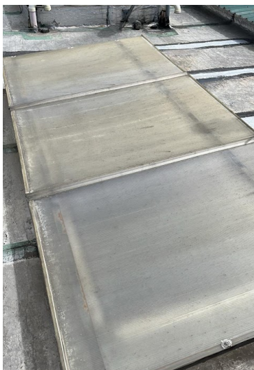
Mantenimiento, cambio de policarbonatos en cubiertas de torres 2, 3, 4 y 5
