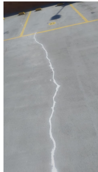
Mantenimiento grietas parqueaderos
